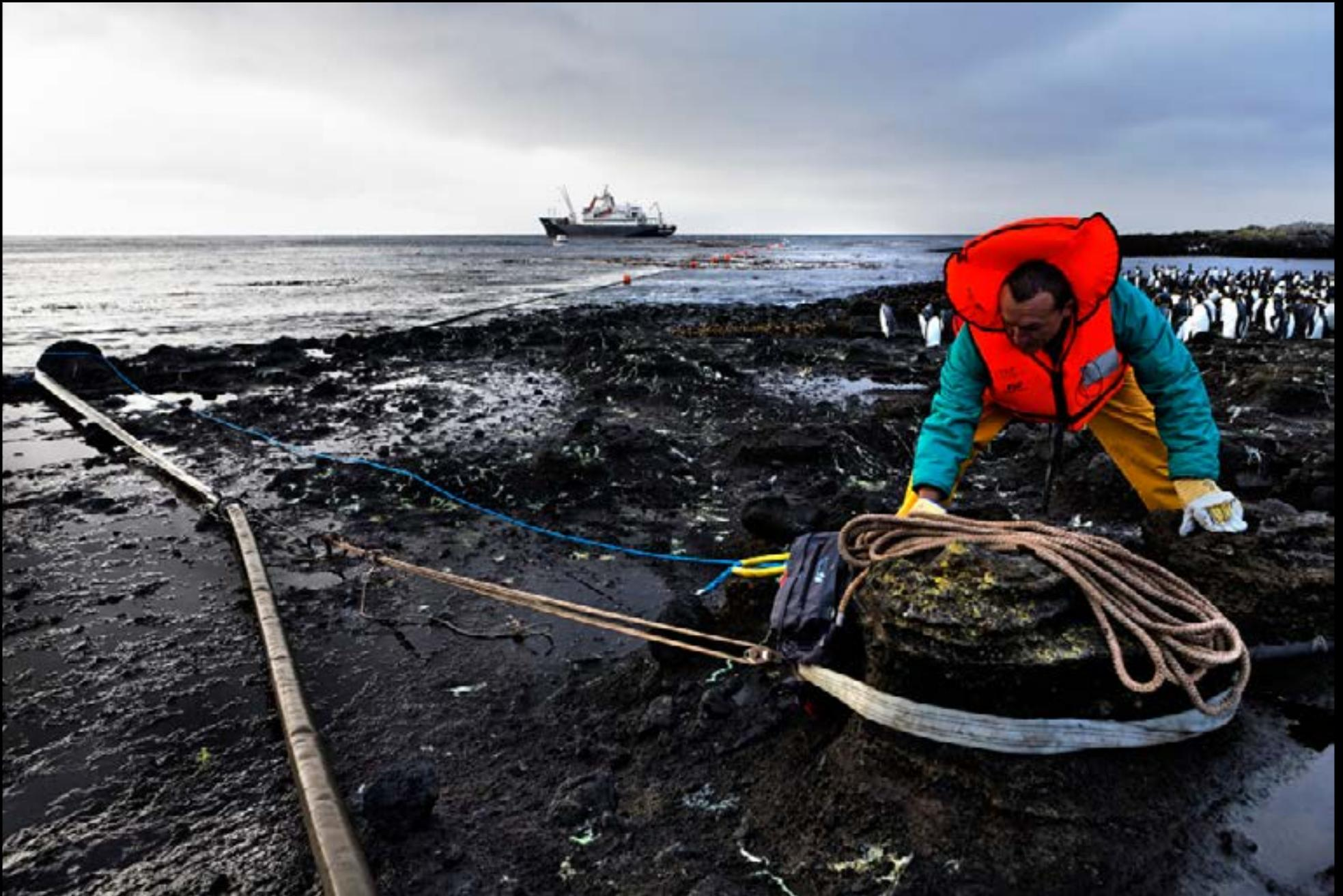
Un homme d'équipage récupère la manche à gasoil. Elle doit être raccordée au système de stockage de la base.
